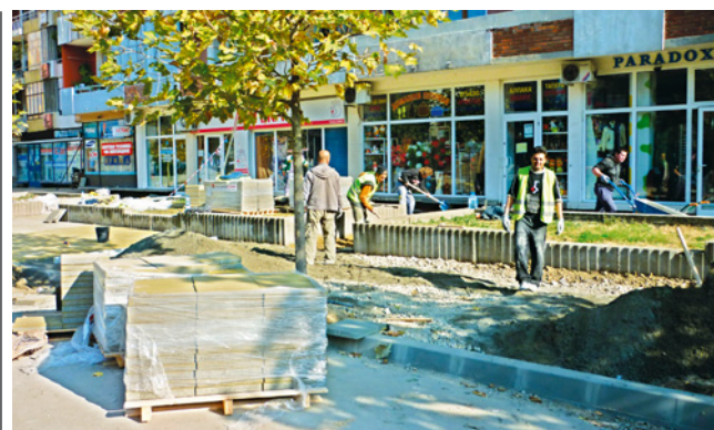
Ремонтните дейности в централната част на града
