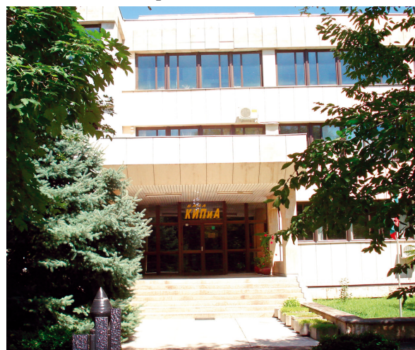
База КИПиА – единственият център в страната, обслужващ жп транспорта в областта на ремонта на скоростомерни инсталации за локомотиви и проверка на средства за измерване на параметри на железния път
